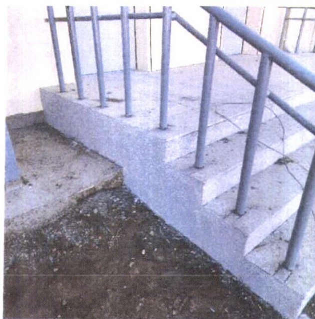
Шат довжооны чулуун шал хийсэн байдал
