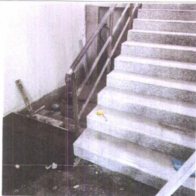
Шат довжооны чулуун шал хийсэн байдал
