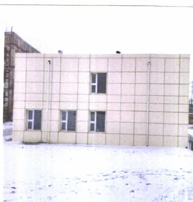
Гадна фасадны силикон, усны хаялга хийсэн байдал
