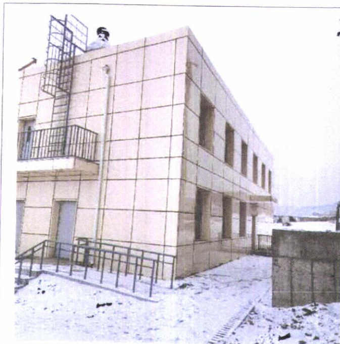
Гадна фасадны силикон, усны хаялга хийсэн байдал
